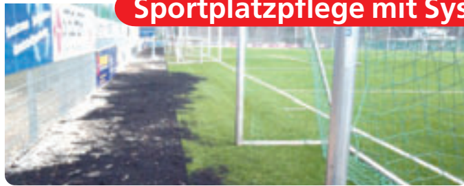
Verluste an Verfüllgranulat durch intensives Schneeschieben.
