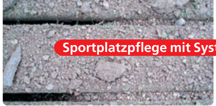
Verfüllung der Schlitzte mit Kies.
