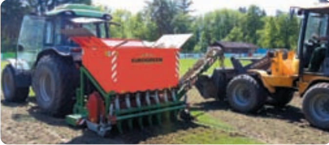
Die Eurodrain-Schlitzfräse bei der Arbeit.
