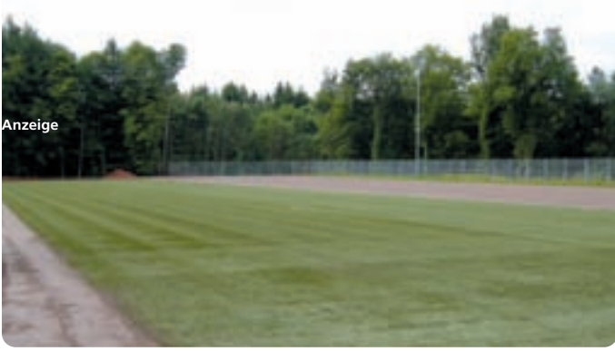
Juni: Umbau eines Tennensportplatzes mit Verlegung des Hybridrasens in der Mittelachse.
