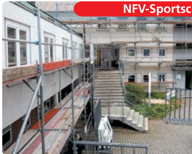
Zur energetischen Sanierung gehört auch die Wärmedämmung der Fassade von Haus 1. Fotos (2): Burkhard
