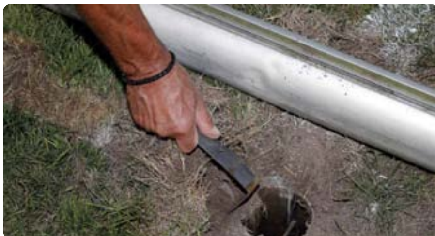
Fachmännisch zerlegt. Der zurück gebliebene Stumpf eines der beiden demontierten Torpfosten.
