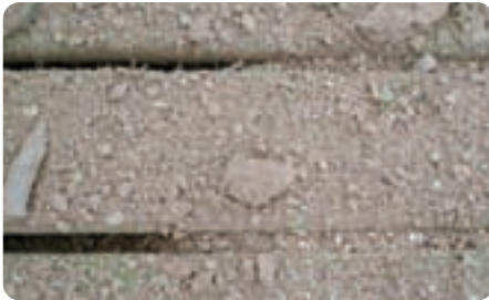
Verfüllung der Schlitze mit Kies.
