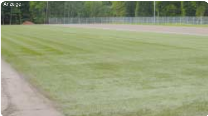
Juni: Umbau eines Tennensportplatzes mit Verlegung des Hybridrasens in der Mittelachse.
