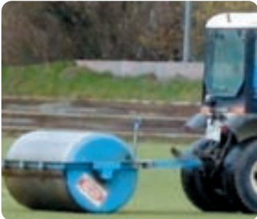
Walzen verdichtet den Boden.
