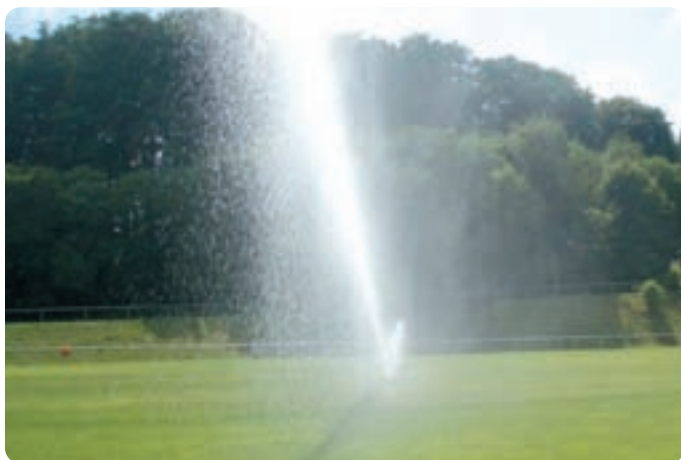
Mit der Versenkbergnung ist eine schlagkräftige Bewässerung des Sportplatzes möglich.
