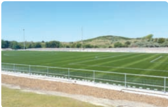
Auf der Insel Borkum wurde ein Belagswechsel notwendig.
