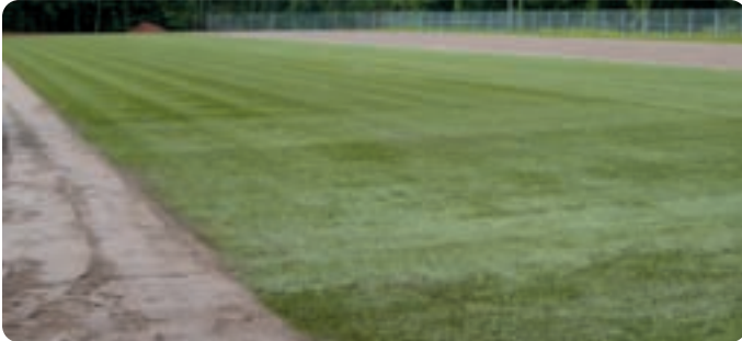
Juni: Umbau eines Tennensportplatzes mit Verlegung des Hybridrasens CombiGrass in der Mittelachse.
