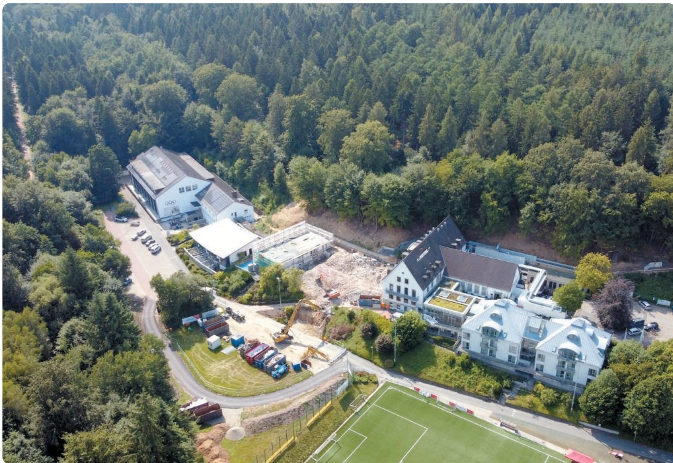
15 Tage nach Beginn der Arbeiten waren der Gebäudeteil B sowie das Dachgeschoss des Gebäudes A bereits abgerissen. Gegenüber dem gelben Bagger ist der C-Platz der NFV-Akademie zu sehen, der als Baustellenzentrale dient und auf dem die Container stehen, in denen der Bauschrott getrennt entsorgt wird. Um den C-Platz herum entstand eine kurze Umgehungsstraße.
