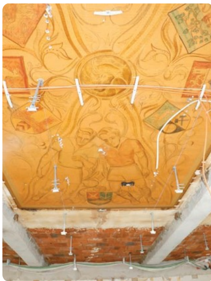
Bei den Renovierungsarbeiten im Restaurant wurden die ursprünglichen Malereien an den Decken und Wänden freigelegt. Sie zeigen Fußballmotive.
