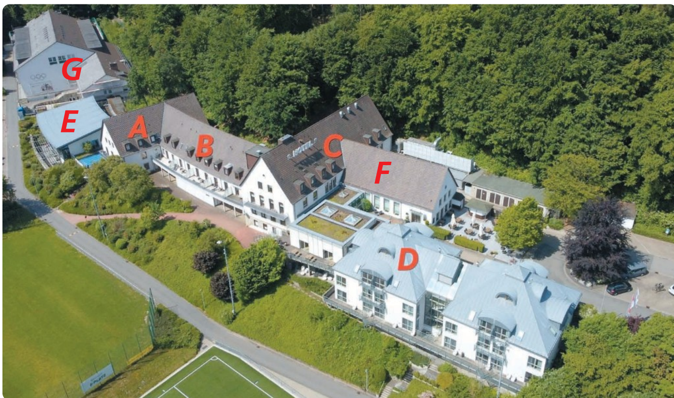
Das Sporthotel Fuchsbachtal vor Beginn der Bauarbeiten.
