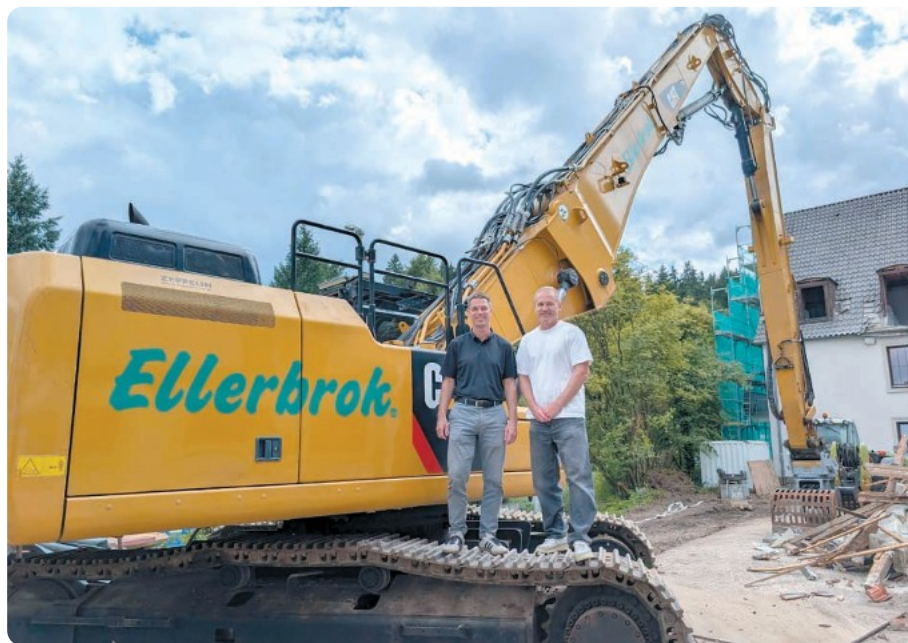
Sind mit der Auslastung des Hotels, das einen Teilbetrieb aufrechterhält, zufrieden: Die NFV-Direktoren Steffen Heyerhorst (links) und Jan Baßler, die zusammen mit Bernd Dierßen die Geschäfte des Sporthotels führen. Das Bild entstand am zweiten Abrisstag nach Beendigung der Arbeiten.
